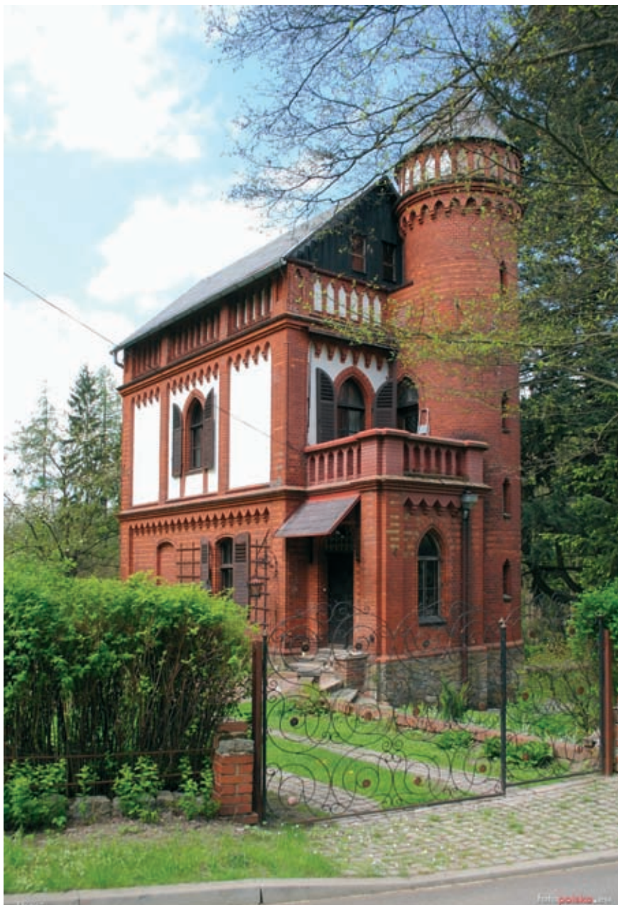
Fot. 2. Dawne obserwatorium meteorologiczne. Obecnie dom mieszkalny. Pierwotnie budynek pokrywał płaski dach, na których znajdował się taras; fot. Piotr Frydrych. Źródło: https://fotopolska.eu [dostęp: 19.10.2019r.].
